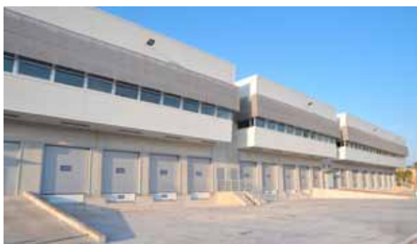
Vista del pabellón Multiservicio III, donde se ubicarán empresas del sector alimentario especializadas en aportar valor añadido a los alimentos frescos
